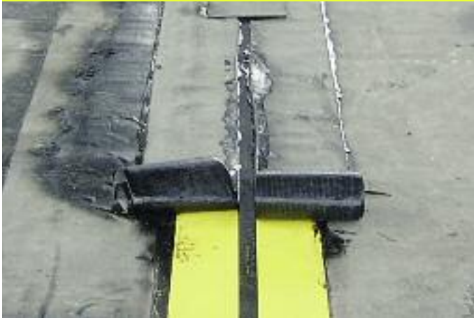
Planebener Einbau (keine störenden Schlaufen und Wülste)
